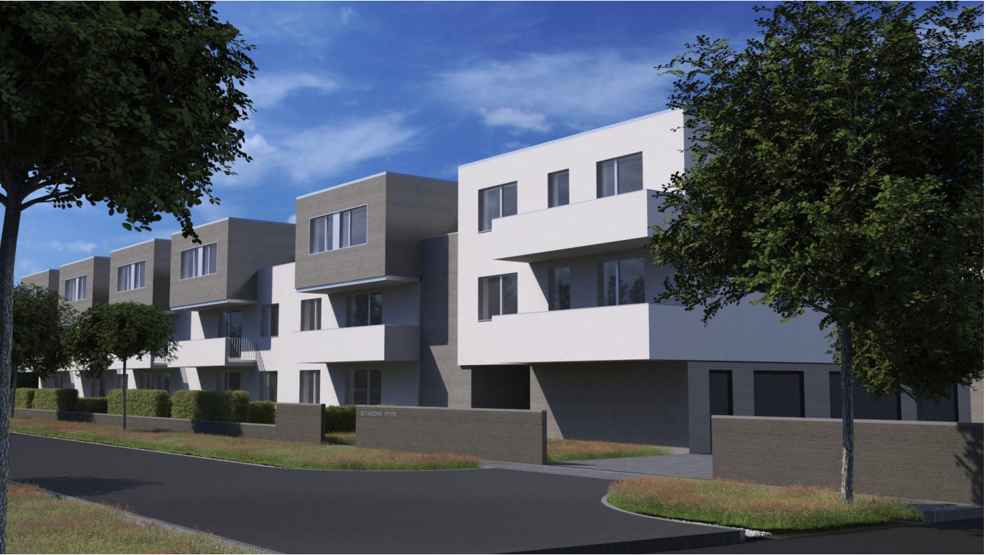
utcakép - keleti homlokzat
